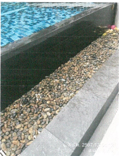
รูปภาพที่ 2.29 รางระบายน้ำล้นรอบสระว่ายน้ำ
