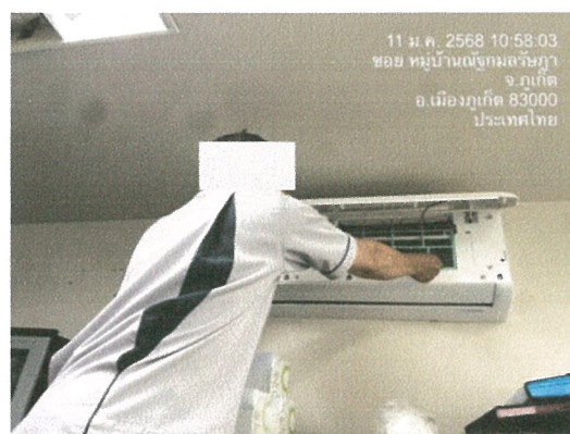
รูปภาพที่ 2.58 การทำความสะอาดเครื่องปรับอากาศ
