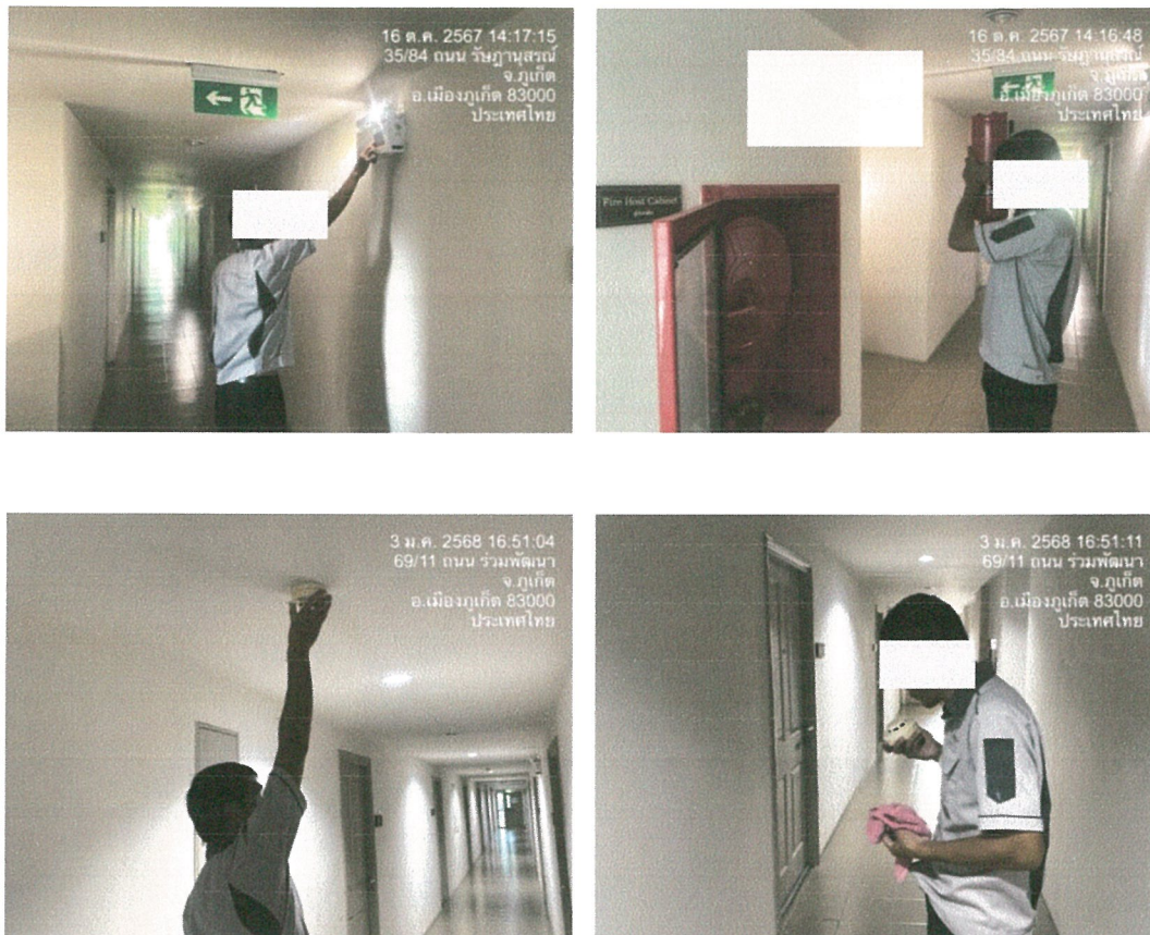
รูปภาพที่ 2.48 การตรวจสอบประสิทธิภาพของอุปกรณ์ป้องกันและแจ้งเตือนอัคคีภัย
