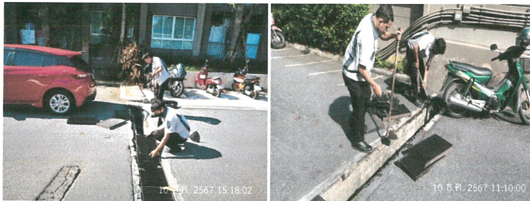
รูปภาพที่ 2.51 การขุดลอกตะกอน
